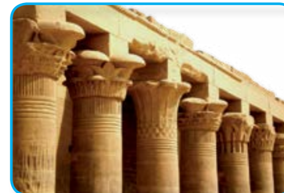
Sistema adintelado con detalle de capiteles egipcios.
