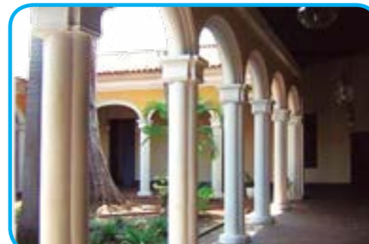
Corredores y patio interno. Casa de los Celis, Valencia.
