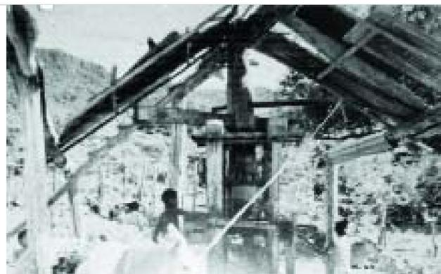
en torno a un eje que produce el movimiento articulado de dos masas de madera, entre las cuales se introduce la caña, permitiendo que éstas la trituren para extraer el jugo, que luego es utilizado en la fabricación de panelas. Aun este trapiche sigue siendo fuente de empleo para los pobladores locales quienes lo usan para elaborar panelas.
