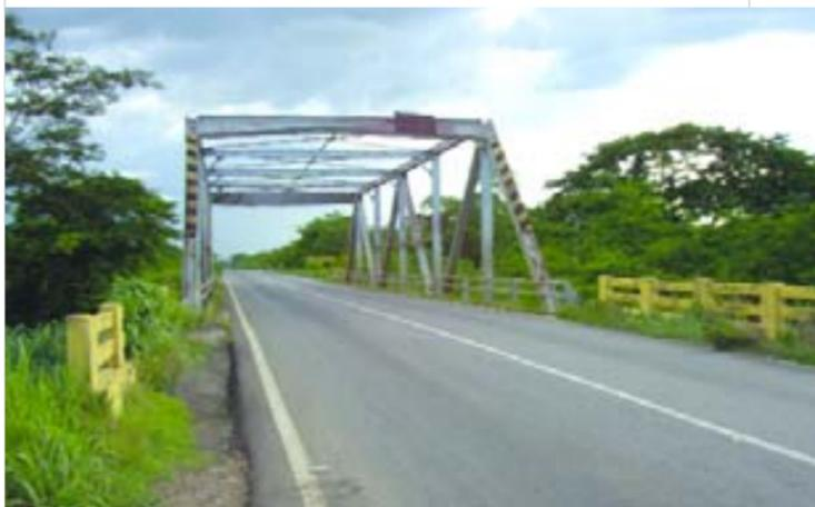
La construcción del Puente Don Pancho data alrededor del año 1930. Su estructura está compuesta por columnas gruesas de hierro. Mide 5 m de altura por 4 m de ancho y 10 m de largo. Construido sobre el río Matícora, se encuentra en uso actualmente y presenta buen estado de conservación. Sigue siendo la vía entre los estados Falcón y Zulia, comunicando además al Municipio Mauroa con otros de la región. La comunidad lo valora como uno de sus más importantes patrimonios históricos.
