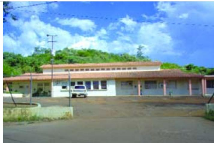
creto armado en estructura, paredes de bloques frisados, puertas y ventanas de vidrio, hierro y madera, y techos de losas de concreto con tejas criollas a dos aguas.
