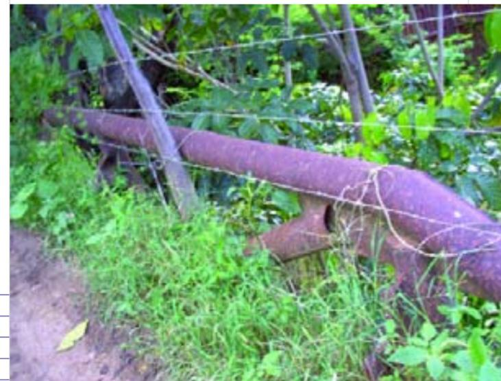
de hierro en cada lado, en el soporte tiene vigas de cemento y la plataforma está fabricada con tubos largos de hierro, recubiertos con cemento.
