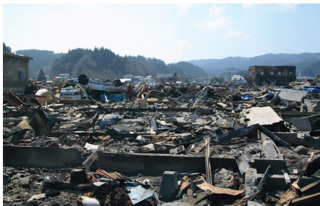
Figura 3.12. Un tsunami, como el que afectó a Japón en 2011, recorre el mar a alta velocidad en una serie de olas extremadamente largas y bajas. Al llegar a la tierra, se alza hacia atrás, absorbe agua y se estrella sobre la tierra costera.
